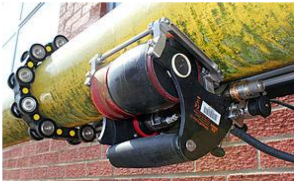
UT en Soldaduras de Cañería de Gas (4")
